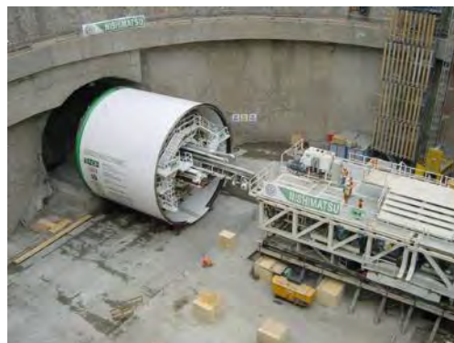
Figur 5-60 Eksempel på opstilling af TBM i startkammer (Dublin Port Tunnel).
