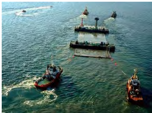
Figur 5-50 Eksempel på transport af sænketunnelelement (Øresund)
