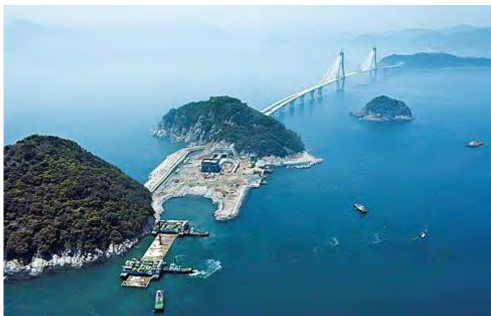
Figur 5-56 Den faste forbindelse Busan-Geoje set mod vest. Sænkning af det vestlige tunnelelement.
